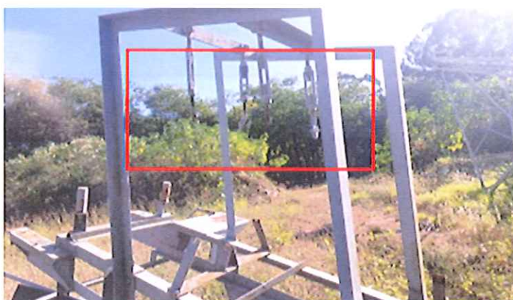
Falta do separador magnetico
